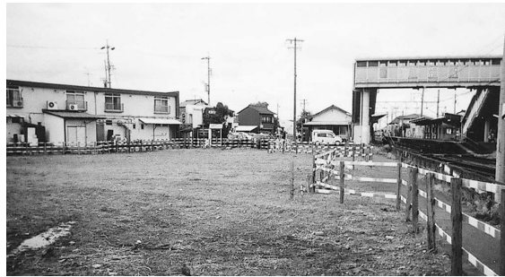
開発が進む勝幡駅前
