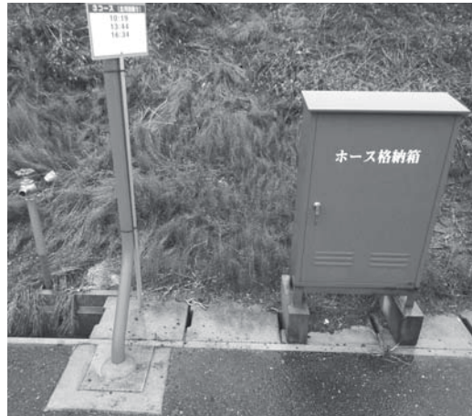
佐織地区の簡易消火栓
