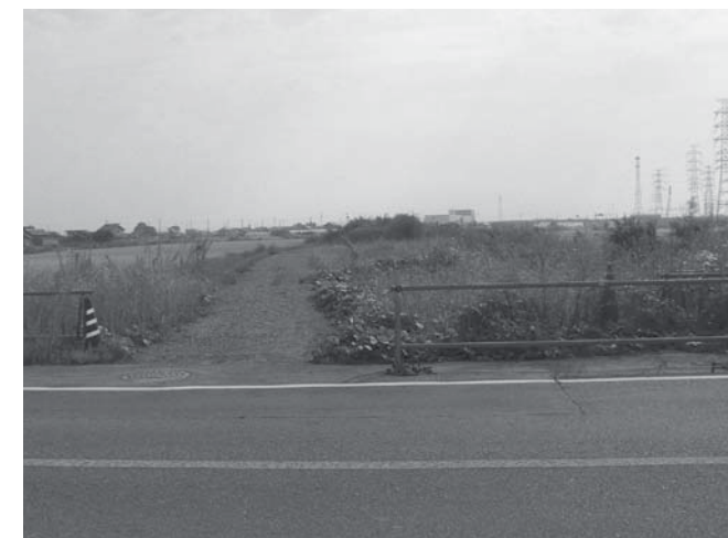
県道富島・津島線の東側工事区間
