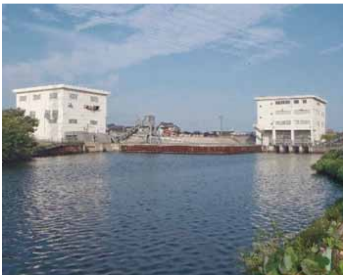
孫宝排水機場の全景
