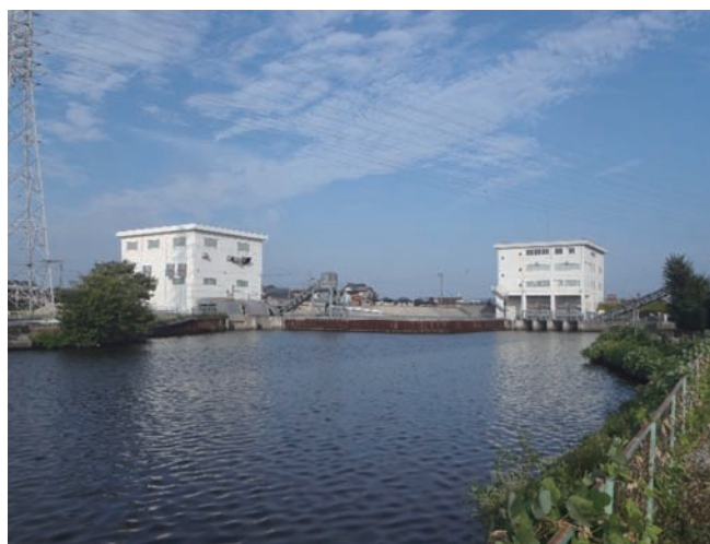
現在の孫宝排水機場
