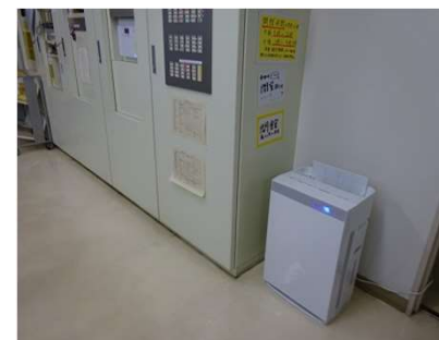
事務室 空気清浄機設置
