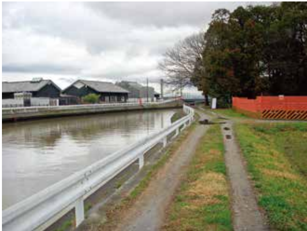
▲道の駅、川を挟み東西2つの公園を工事中
