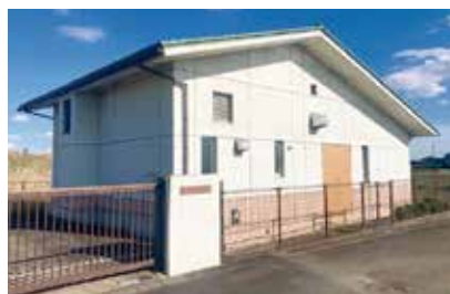
▲西八幡団地浄化センター
