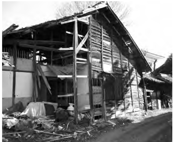
▲空き家の現状
