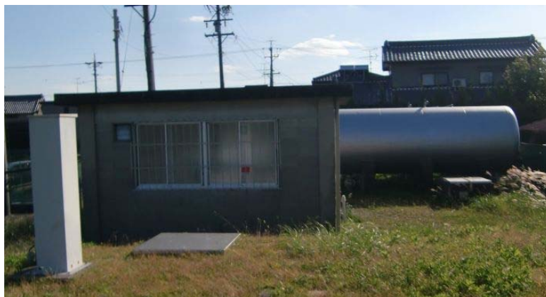
(前方) 佐織西部ポンプ室 (コンクリートブロック製:S46 年築) (後方) 圧力タンク (鋼板製:S46 年築)
