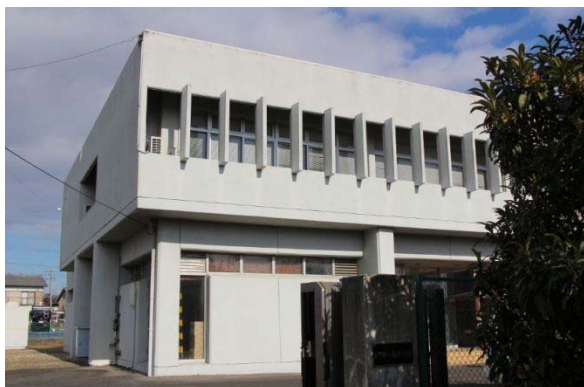
佐織中部浄水場 管理本館
