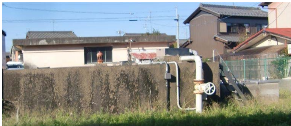
(前方) 佐織中部塩素混和池 (鉄筋コンクリート製) (後方) ろ過ポンプ室 (鉄筋コンクリート製)
