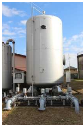
佐織中部浄水場の急速ろ過機
