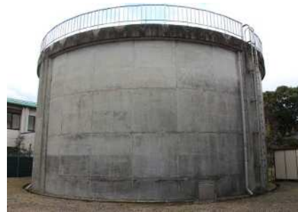
八開浄水場の配水池
