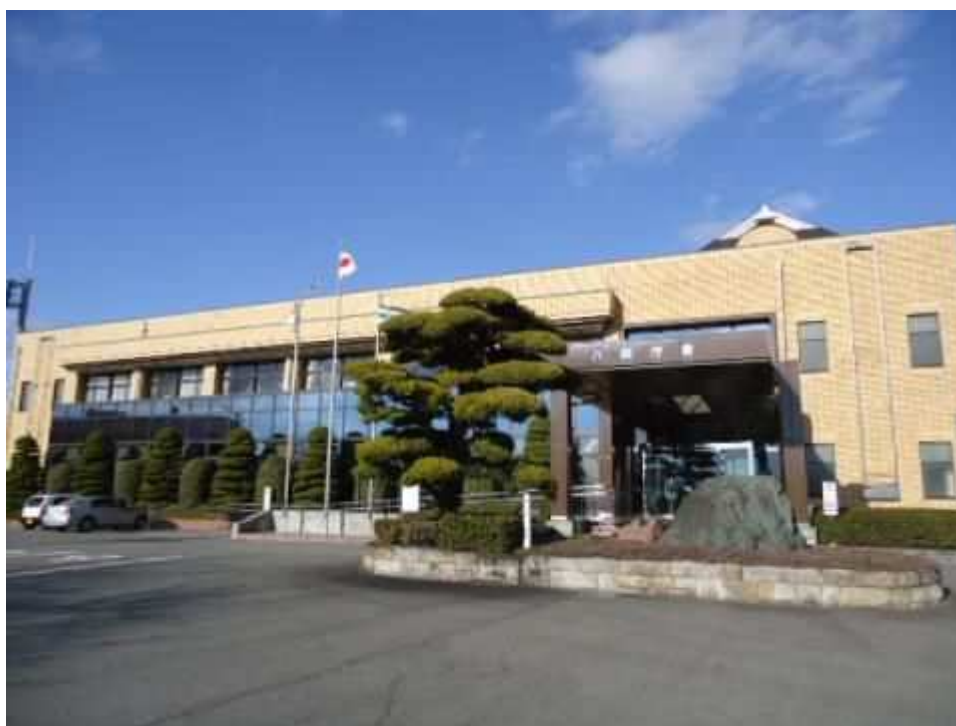
水道業務を行っている愛西市役所八開庁舎
