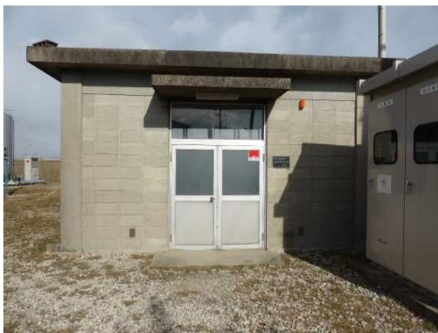
佐織西部ポンプ室 (コンクリートブロック造：S45年度築造)
