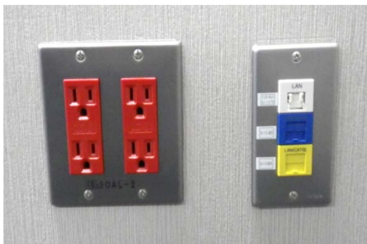
図 3 非常用電源から電力供給される赤いコンセント
