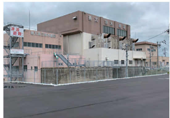
現在の善太川排水機場とガスタービン式ポンプ 左から善太第三、善太新、善太第二排水機場
