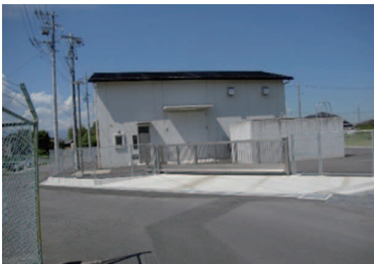
鷹場排水機場
