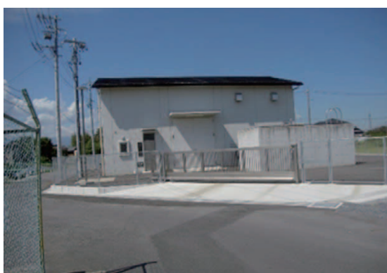
鷹場排水機場
