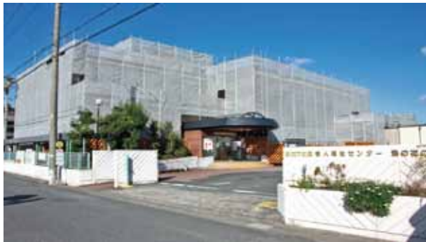
▲工事が進む天然温泉の「湯の花の里」
