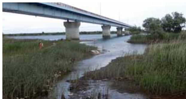
立田大橋の橋脚下部で、潮位差を示す写真
