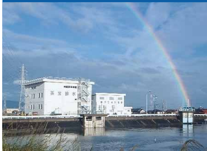
(孫宝第2排水機場・新孫宝排水機場)
