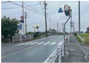
西川端橋北横断歩道
