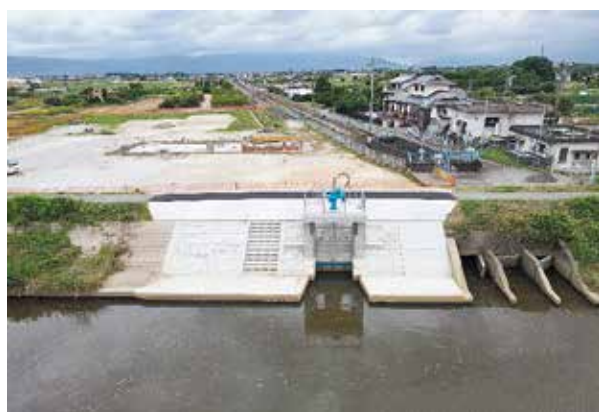
新設排水樋門
