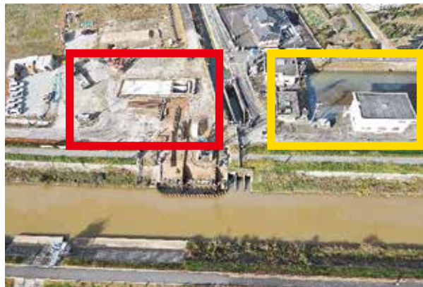
写真 赤枠 は建設中の八開排水機場、 黄枠 が既設排水機場
