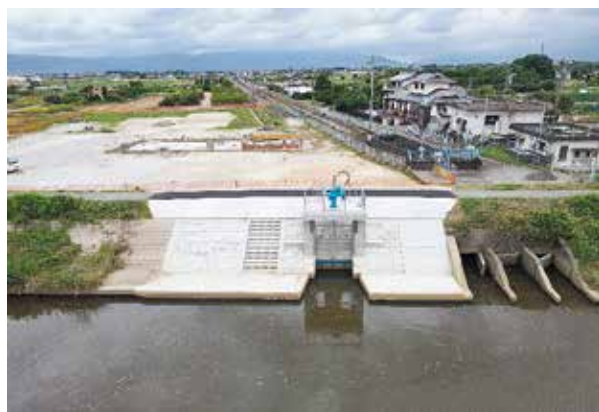
新設排水樋門
