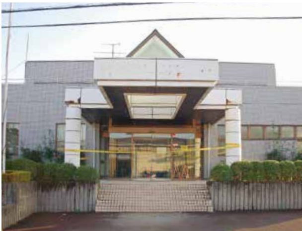
▲利活用されず、解体予定の旧立田福祉会館
