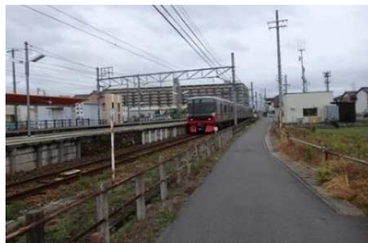
駅東側の狭あい道路
