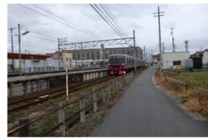
駅東側の狭い道路
