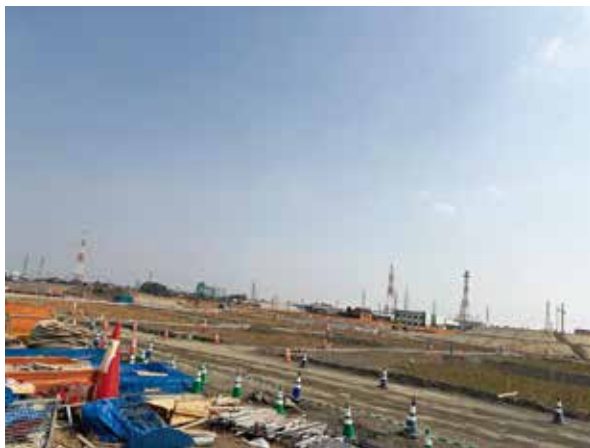
▲工事中の道の駅東ゾーン
