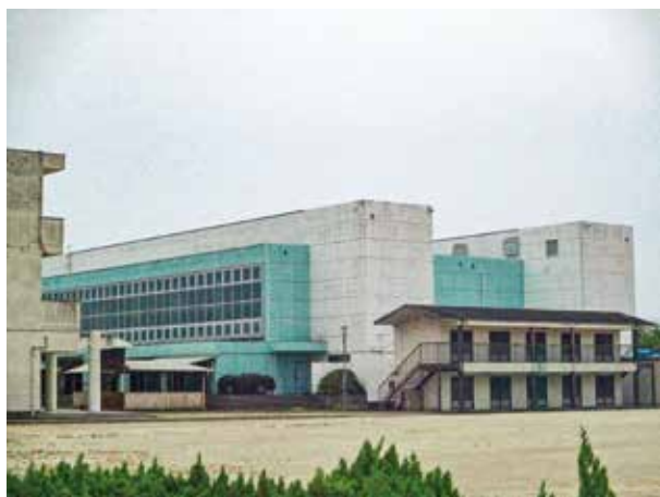
▲老朽化した永和中学校体育館
