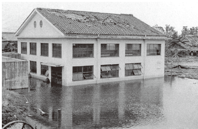
(浸水した孫宝排水機場)
