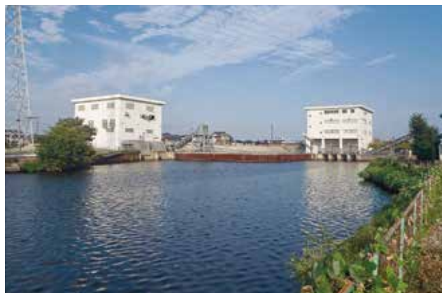
(新孫宝排水機場・孫宝第2排水機場)
