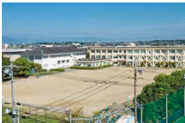
▲校舎新築早期着工が望まれる佐屋小学校
