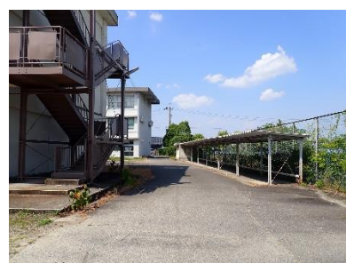
屋内運動場へ至る敷地東側の通路
