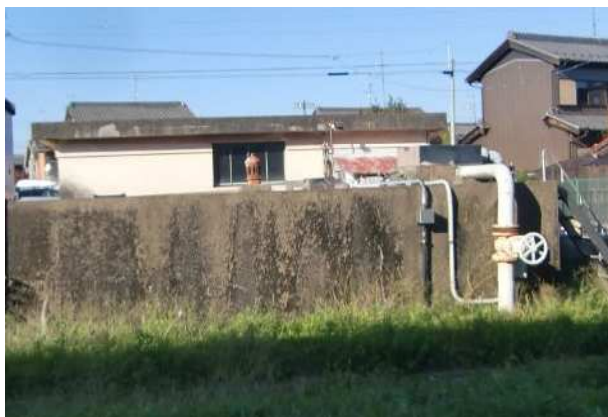
佐織中部塩素混和池 (鉄筋コンクリート造:S48 年度一部更新)
