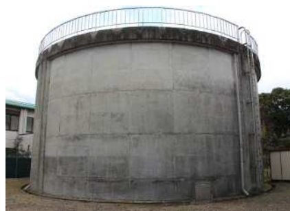
八開浄水場の配水池
