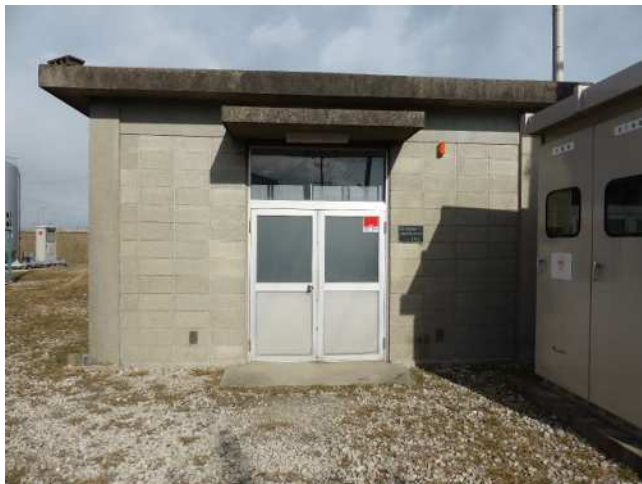
佐織西部ポンプ室 (コンクリートブロック造:S45 年度築造)
