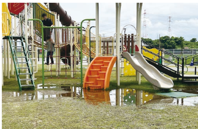
▲検証後も改善されない公園の排水問題（6月撮影）
